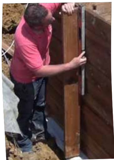
Contrôlez l'aplomb des renforts.
